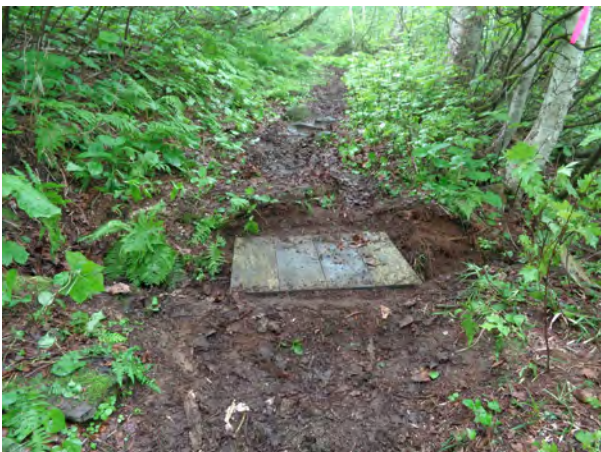
4-3 E地点補修後
