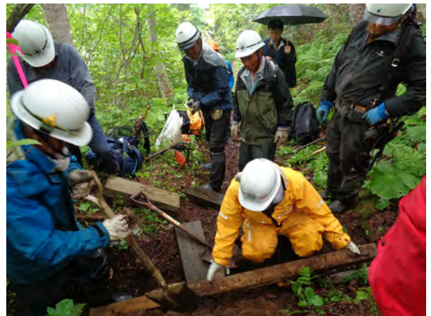
4-2 E地点補修中
