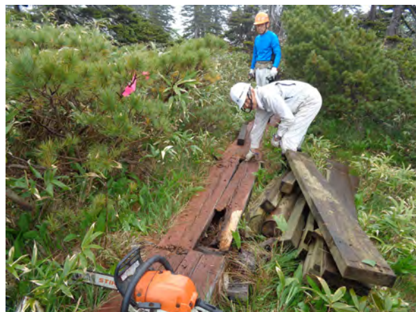
2-1 B地点補修前
