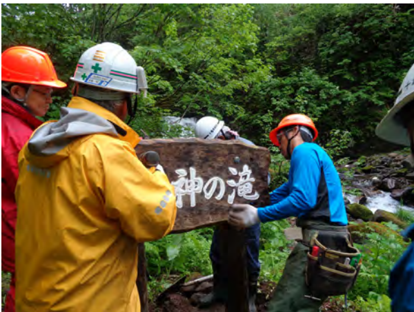
2 女神の滝看板移設作業中②
