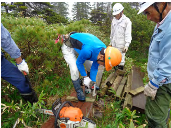
2-2 B地点補修中
