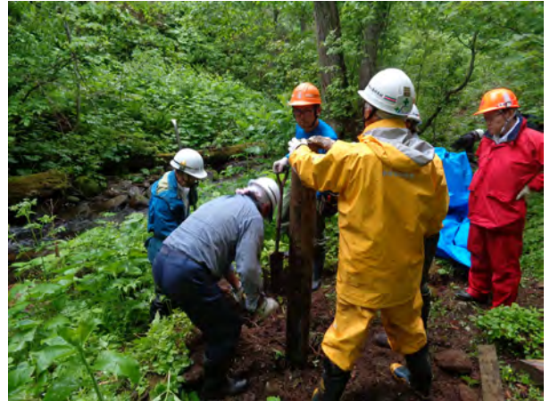
2 女神の滝看板移設作業中①
